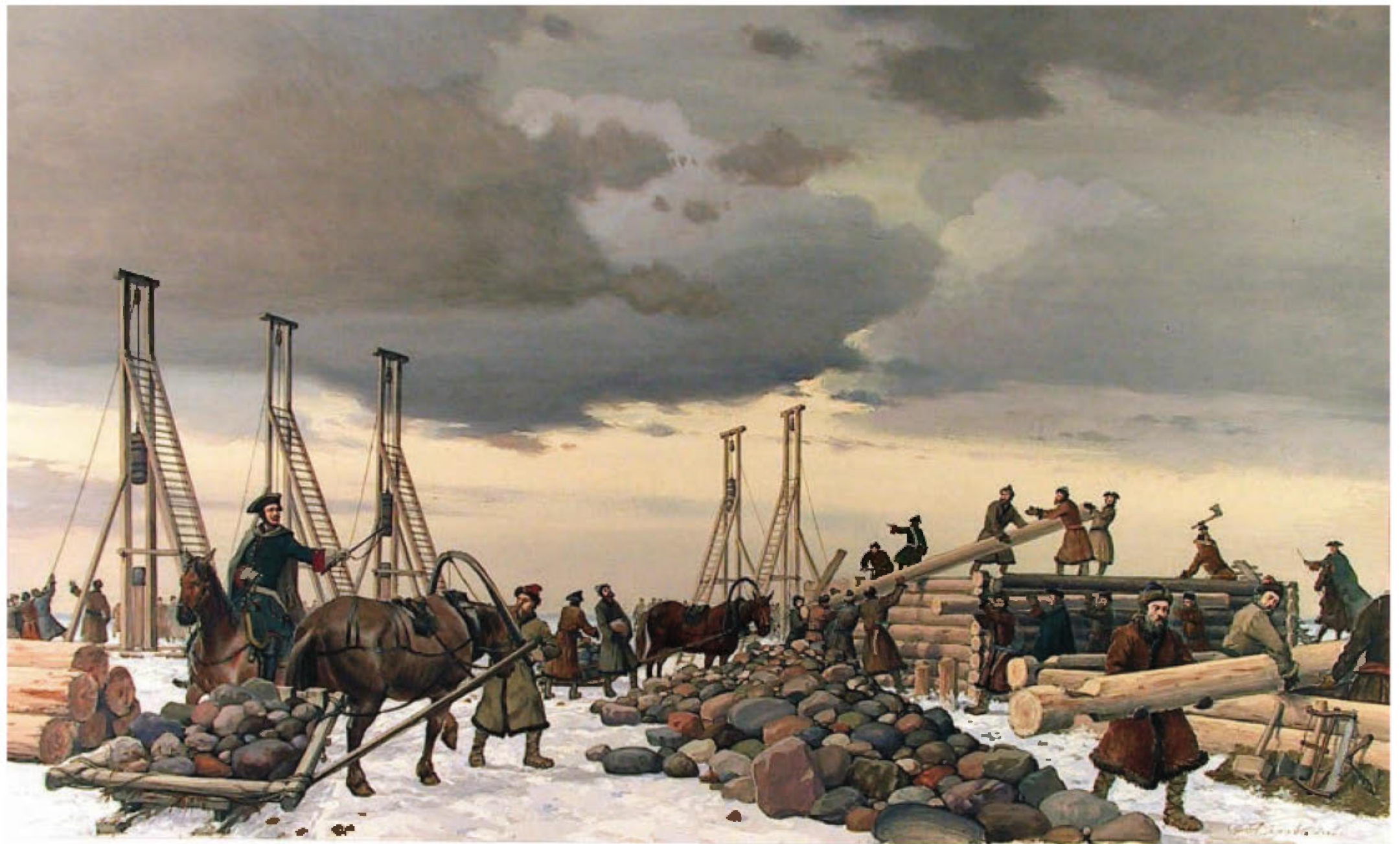
Строительство форта Кроншлот.
