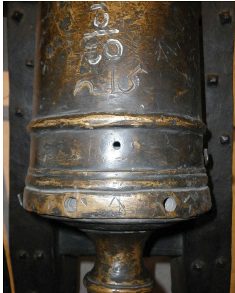
Ил. 4. Запал и торельный пояс пушки ВИМАИВиВС МЧА 02/2
