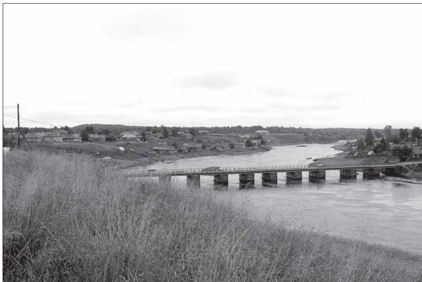
Вид на мост через реку Нюхча с Николиной горы. (Мост сооружён одним из традиционных русских способов: ряжи из брёвен заполнены внутри камнями и грунтом.) Нюхча, 25 августа 2008
