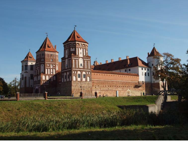
кирпичными строениями. Посередине западной стены находится пятая, 6-ярусная башня, которая имела ворота и подъемный мост. Башни (высота 25-27 м) выходят за периметр стен, до 1/3 высоты имеют 4-гранное сечение, выше — 8-гранное, накрыты шатрами, прорезаны бойницами. Нижние ярусы башен имеют каменные помещения, верхние перекрывались помостами на деревянных балках.
