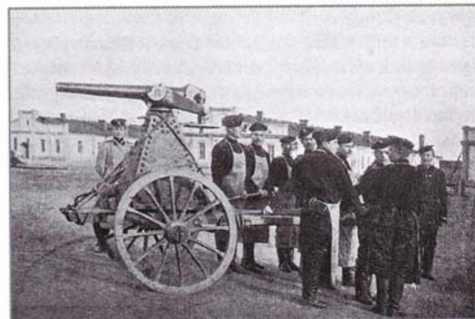
*Наложение 57-мм капонирной пушки с тумбой на тележку чертежа 1867 года*
