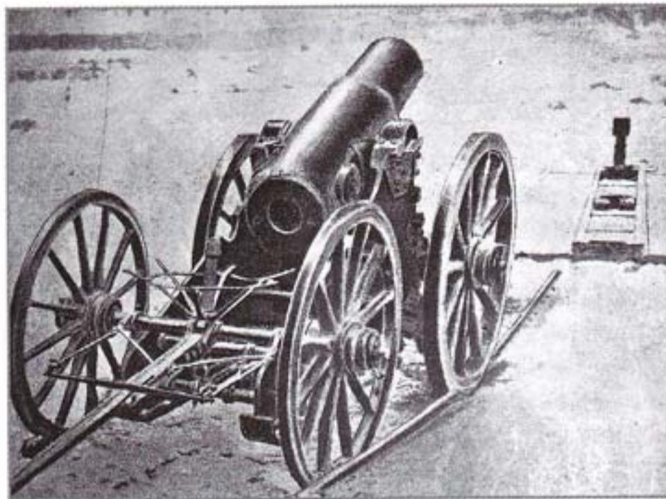
*Крепостное орудие на 8-дюймовом станке с лёгким крепостным передком*
