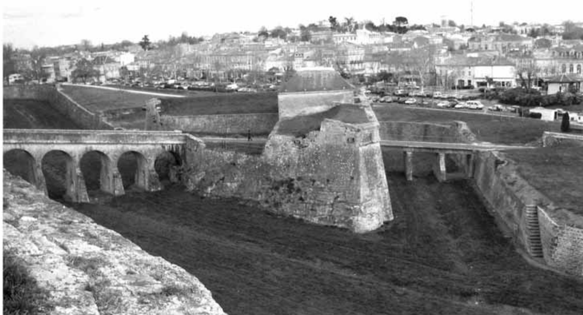
Рвы, равелин и система мостов (въезд в город) крепости Бле, построенные Вобаном.
