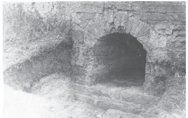
Рис. 16-17. — Бойница подошвенного боя Южной башни (обмерный чертеж и фото)
