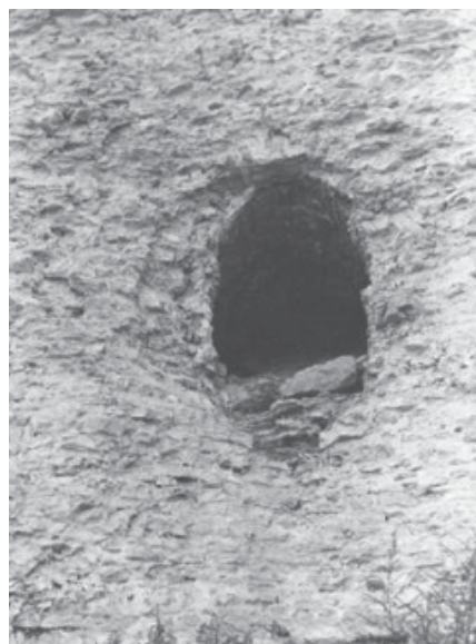
Рис. 26. — Арочный проем и бойница на северном прясле. Наружная облицовка утрачена
