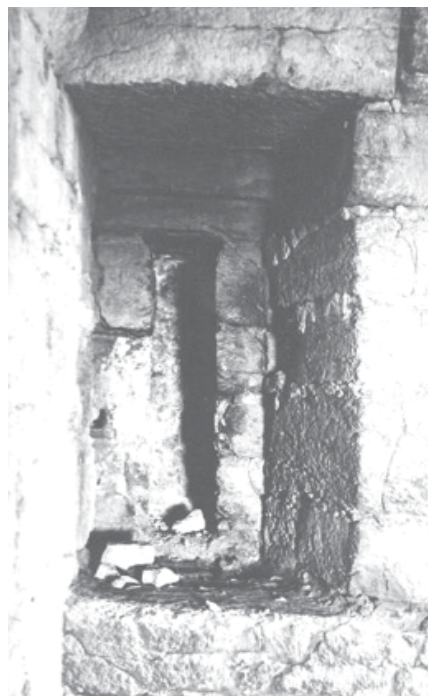
Рис. 23. — Пушечная камера северного прясла с окном-бойницей и дымогарным каналом, выходящими во двор
