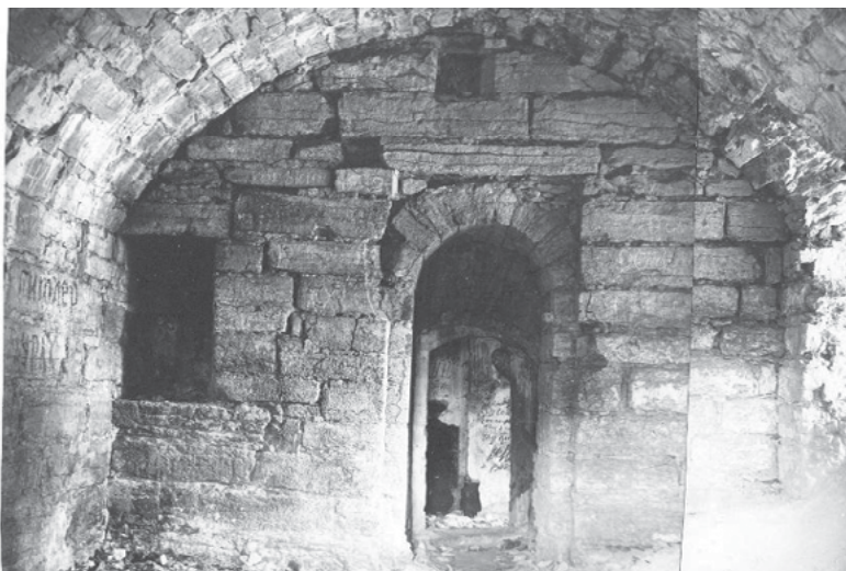
Рис. 23. — Пушечная камера северного прясла с окном-бойницей и дымогарным каналом, выходящими во двор
